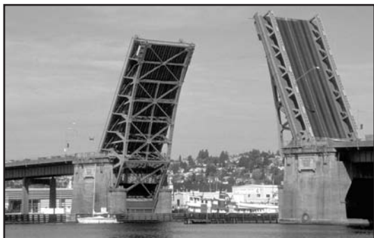
Fig. 52 Pont à bascule s'ouvrant pour la navigation
