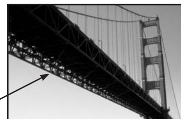
Fig. 49 - L'utilisation de poutres triangulées sur le tablier d'un pont suspendu
